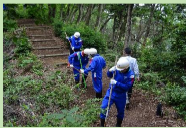
「きずなの森」遊歩道の整備
