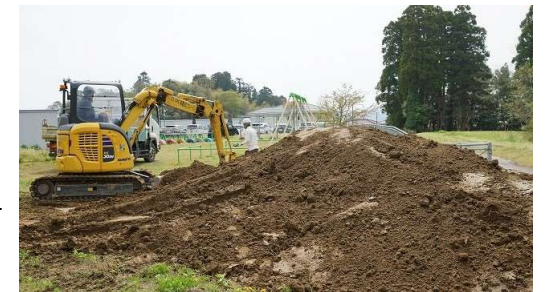
<ビオトープ埋め立ての様子 R8.4.17>
